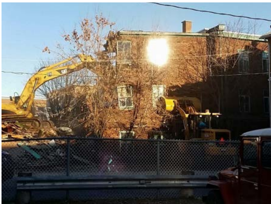
Démolition de l'Hôtel Saint-Étienne à La Malbaie
